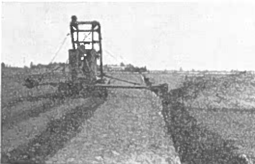
Kuva 9. Avo-ojien puhdistuksessa käytetty kierukkalaite asennettuna 6 tonnin painoiseen telaketjuatraktoriin. (Valok. K. Maijala).
