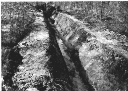
Kuva 1. Ohutturpeisessa hiekkamaassa on auran kärjen kuluneisuus ollut myös osasyynä siihen, että ojan luiskat ovat tulleet liian jyrkiksi ja ojaamat jääneet aivan ojan reunoille.
