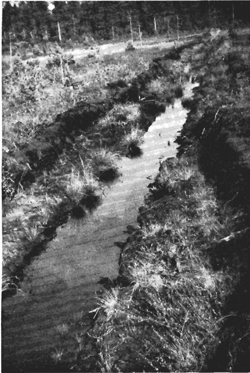
KUVA 1. Syväturpeiset suon keskustat painuvat yleensä enemmän kuin matalaturpeiset reunaosat. Tämä on ehdottomasti syytä huomioida jo ojalinja-verkostoja laadittaessa, sillä muuten saattaa käydä, kuten kuvamme osoittamassa tapauksessa. Kuvat kirjoittajan.
