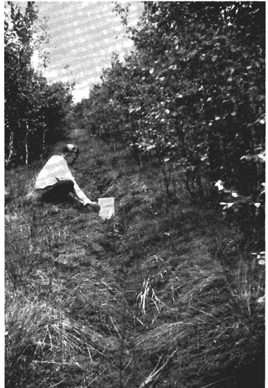
KUVA 2. Erittäin herkkiä tukkeutumaan ovat heikkopotouksiset, vähävetiset ojat. Pienikin turvepaakku tai risu putoaa jo vettä ja seurauksena on nopea sammaloituminen ja umpeenkasvaminen.
