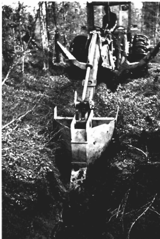
Kuva 2. Umpeutuneen metsäojan avausta metsäojituskaivurilla (JAMES 80 M). Yksikön perkausominaisuuksia parannettu kaivunvakaajalla ja erikoiskauhalla malli MOILANEN. Valok. M. Niskanen.
